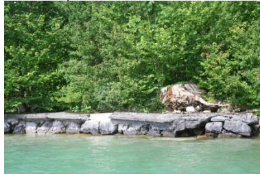
mittel: senkrechte-schräge Steinschichtung, nicht verfugt
